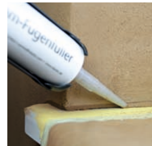
Fugenfüllung mit natur-braun an einer Fensterbank
