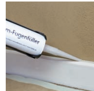
Fugenfüllung mit natur-weiß an einer Sockelleiste
