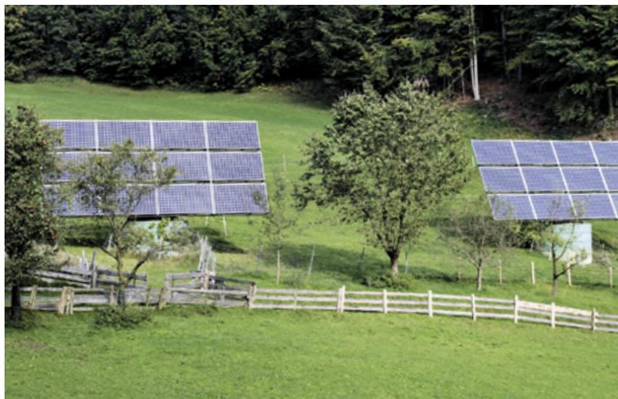
Zwei sogenannte Solarmover liefern ebenfalls Strom. Die Module darauf drehen sich mit der Sonne mit.
