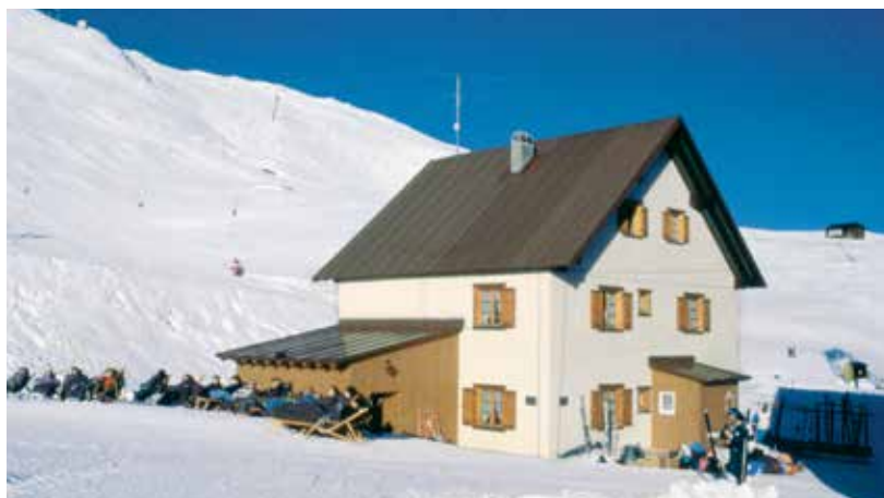
Das erste, noch als Testobjekt geführte Gebäude mit Sto-WDVS steht in alpiner Umgebung und bringt wertvolle Erkenntnisse zu Langzeitverhalten und Effektivität.
