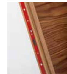
Zum Vergleich: herkömmlich mit außen liegendem Brandschutzlaminat
